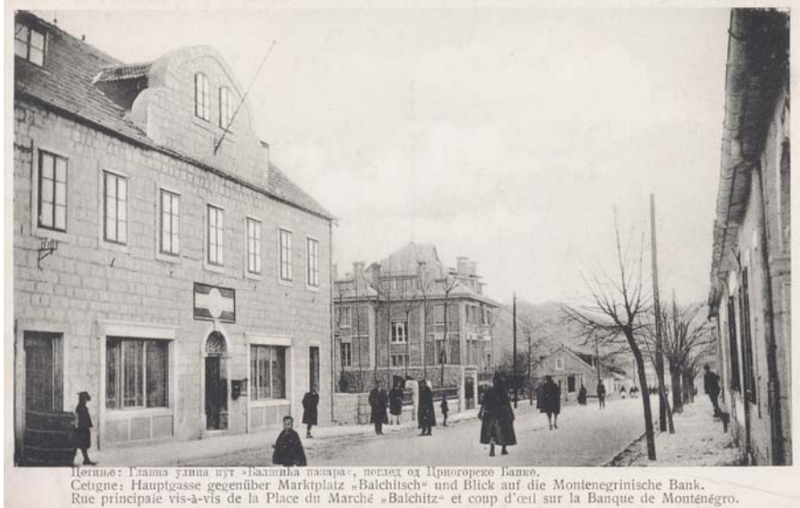
The House of Montenegrin Bank after adaptation in 1911 / Kuća Crnogorske banke nakon adaptacije 1911. godine
